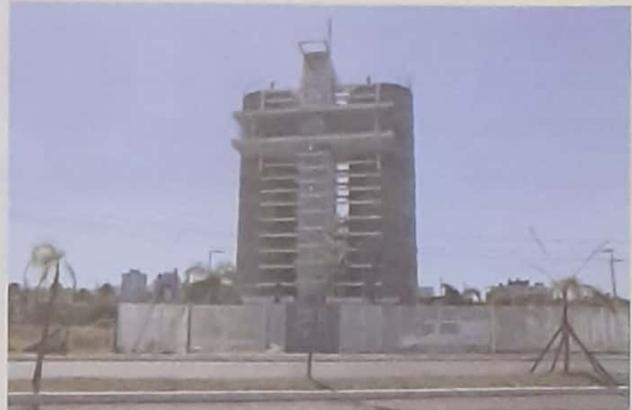
No projeto a casa de bombas da estação está harmonizada com as chaminés de equilíbrio (três torres de concreto aparente, com sete metros de diâmetro, duas delas medindo 26 metros e outra, 12 metros de altura), mais um volume estruturado em vidro e aço cujo mirante, no oitavo andar, permite um ângulo de visão superior a 270° do lago Guaíba.
