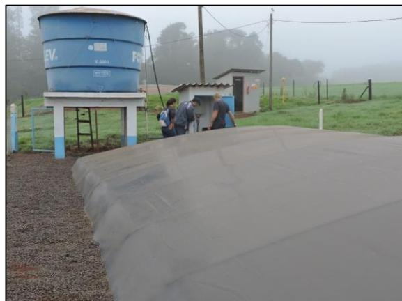
**Figura 7** – Cisterna Coletoras de Água da Chuva com capacidade de 500m<sup>3</sup> de água em uma propriedade rural localizada em Linha Ajuricaba. Fonte: SAAE MCR.
